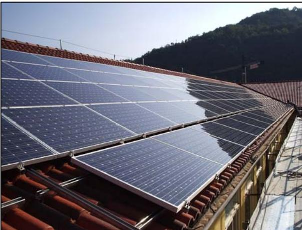
Sistemi grid connected per abitazioni allacciate alla rete elettrica
